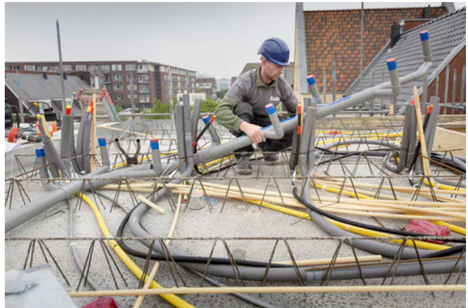
Installatiebedrijf aan het werk bij appartementencomplex in aanbouw in Zwolle. Installatiebedrijven vallen onder de verplichtstelling van PMT. Hollandse Hoogte / Herman Engbers
